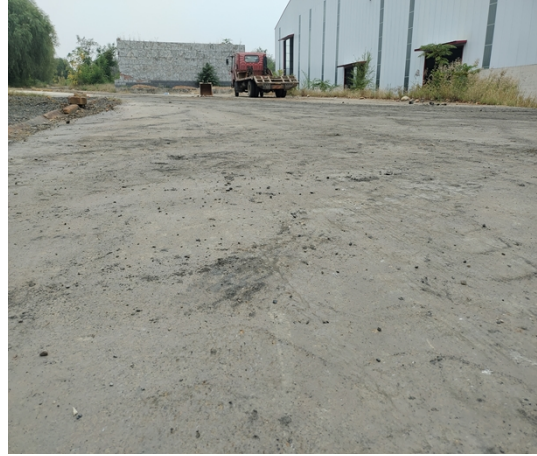
照片 2: 道路广场
