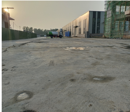
照片 2：道路广场
