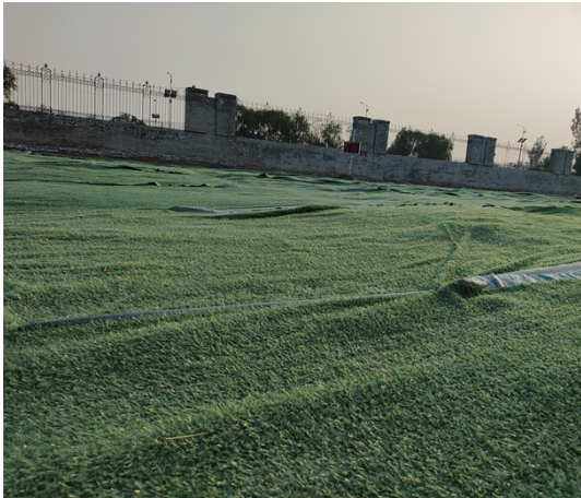
照片 3：临时苫盖
