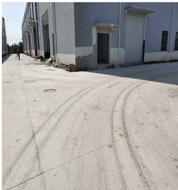
照片 2：道路广场区
