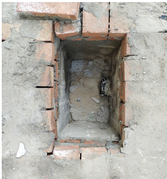
照片 4：临时排水沟
