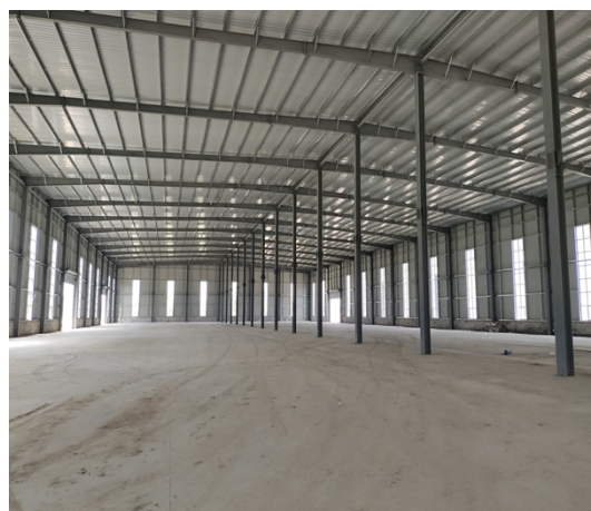
照片 2：钢结构框架
