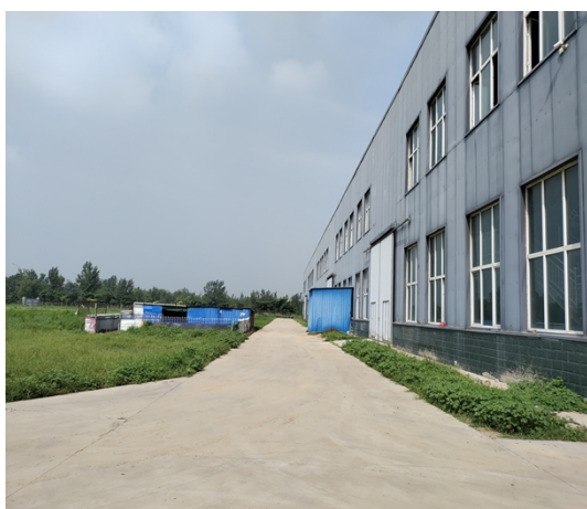
照片 3：道路广场区
