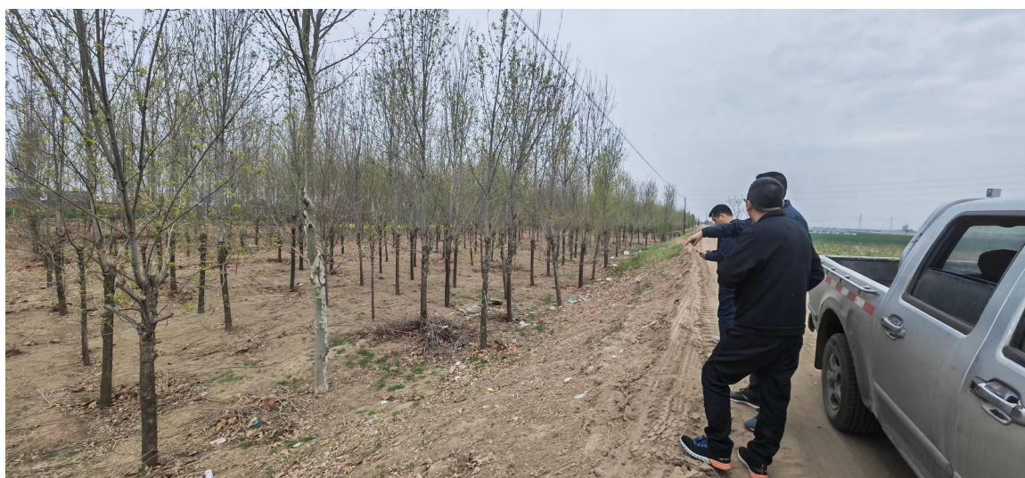
现状 4 雨水方沟工程
