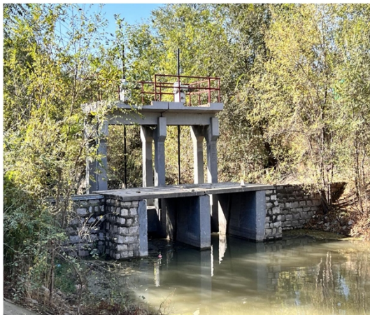
现状 1 水闸及倒虹吸工程区
