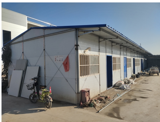
照片 3：施工预制场
