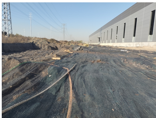
照片 4：临时苫盖
