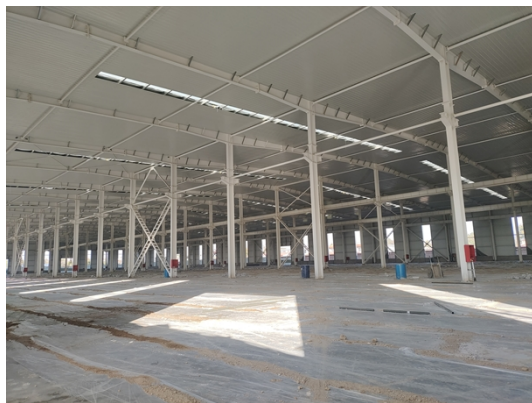
照片 2：1#车间内部
