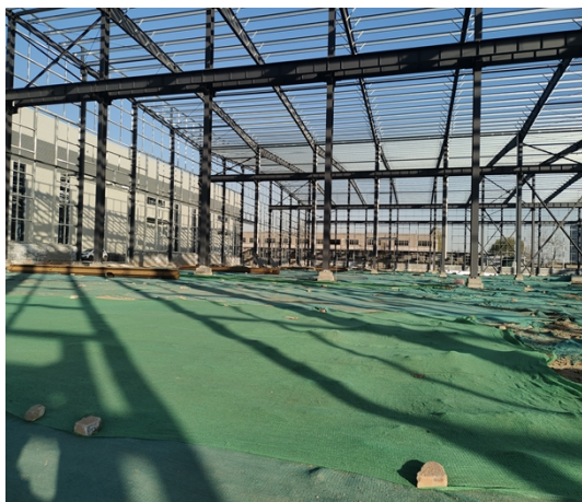
照片 3：临时苫盖
