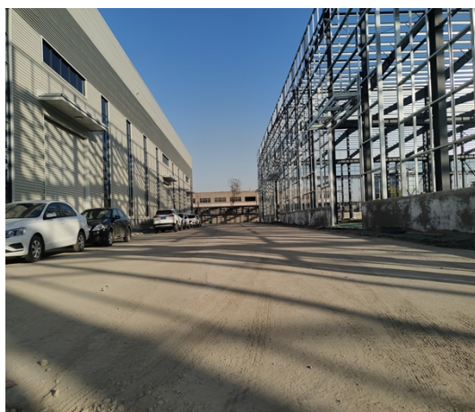
照片 2：道路广场区
