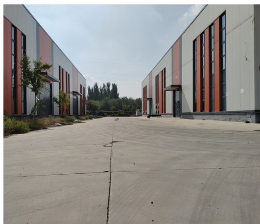
照片 2 道路广场区
